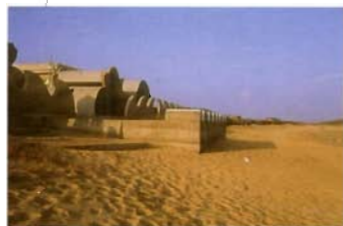
沙灘邊上蓋水泥衛浴設施，不僅造成包護區的沙灘流失，而且將沙灘的入口處墊高，像是城堡一樣，不僅造成遊客的不便，破壞景觀，也造成產卵沙灘進一步的流失。
