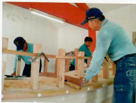
量測五王厝位置與隔板弧度
