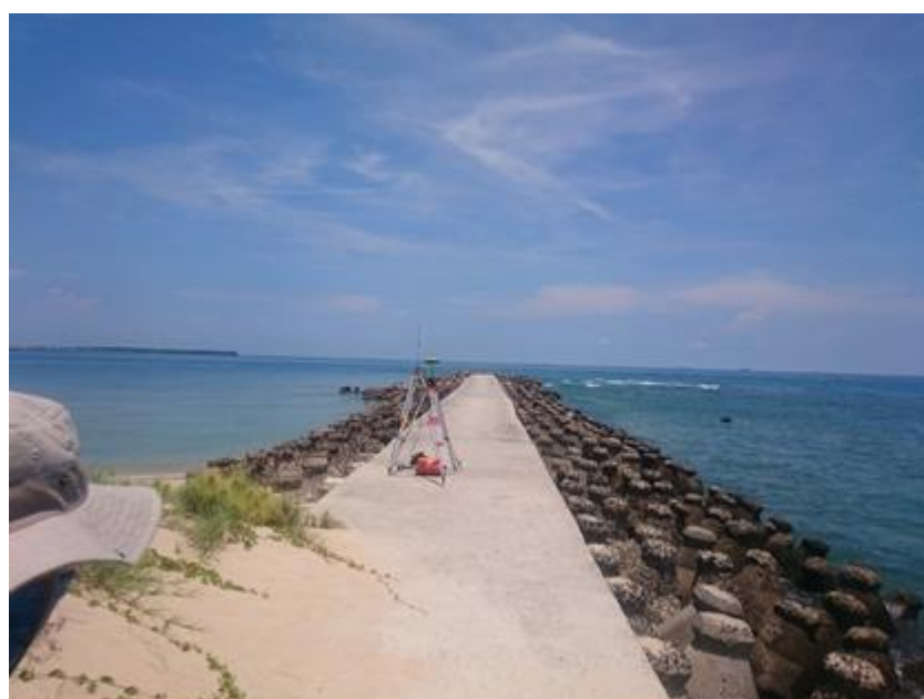
圖十、RTK-GPS 基準站架設(隘門沙灘)
