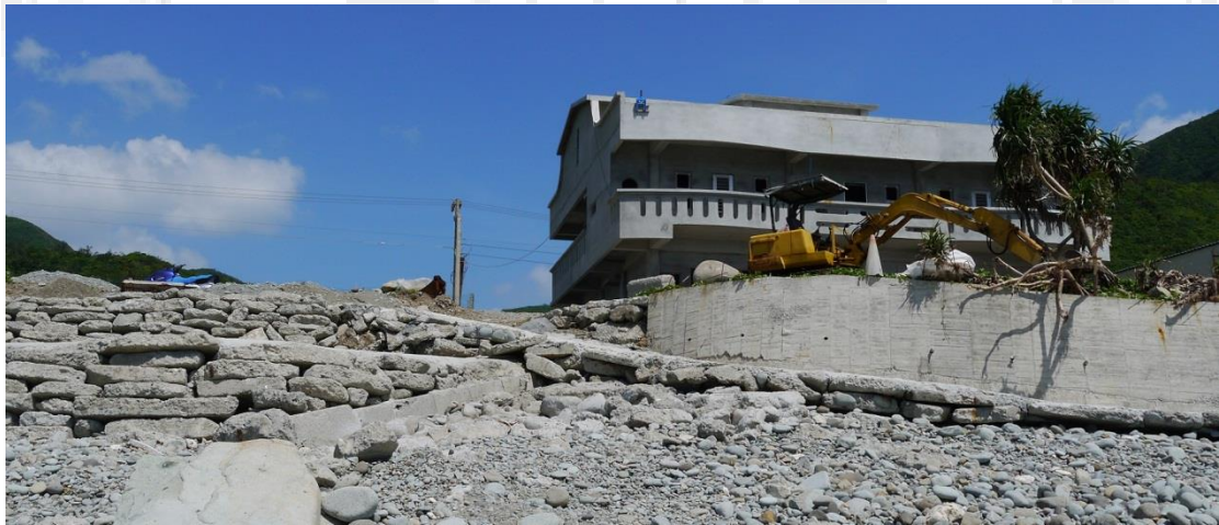
圖八、八代灣上的民宿與防坡堤
