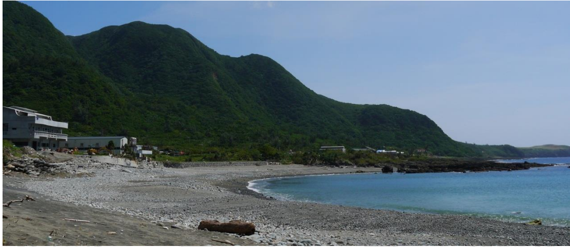
圖七、八代灣內的防坡堤
