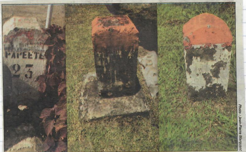
Les points kilométriques sont majoritairement très dégradés.
