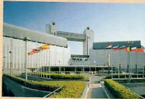
名古屋国際会議場【センチュリーホール】
