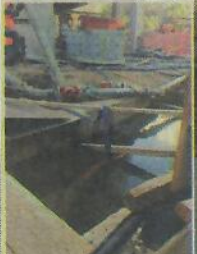
研究顯示，檀香山和威基基大部份地區正處於被地下水淹沒的風險中。小圖為顯示維基基一處工地，漲潮時地下水已接近地面。夏威夷大學馬洛亞分校提供
