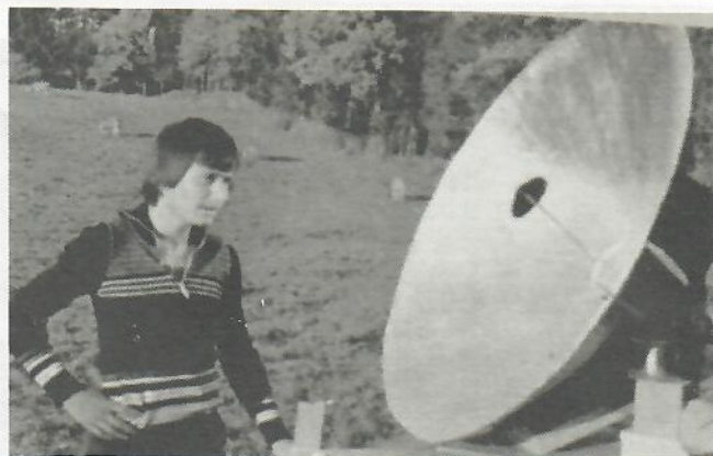
Ruedi Bänziger (15 ans) a construit ce miroir parabolique avec régulateur automatique de poursuite du soleil et thermopompe incorporée — un travail grandiose !
