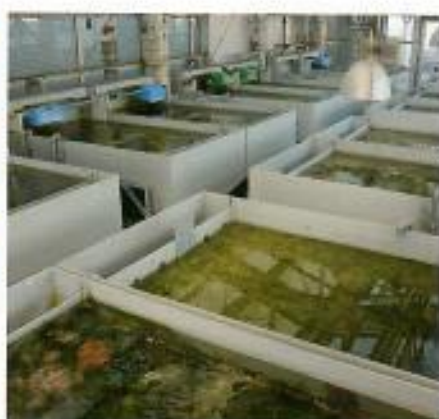
海藻バイオフィルターをはじめとしたサンゴ専用の浄化システム A special water filtering system for corals using seaweed biofilters
