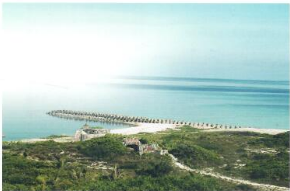
東沙島的沙灘末端，因堆上消波塊而失去擺動的功能。
