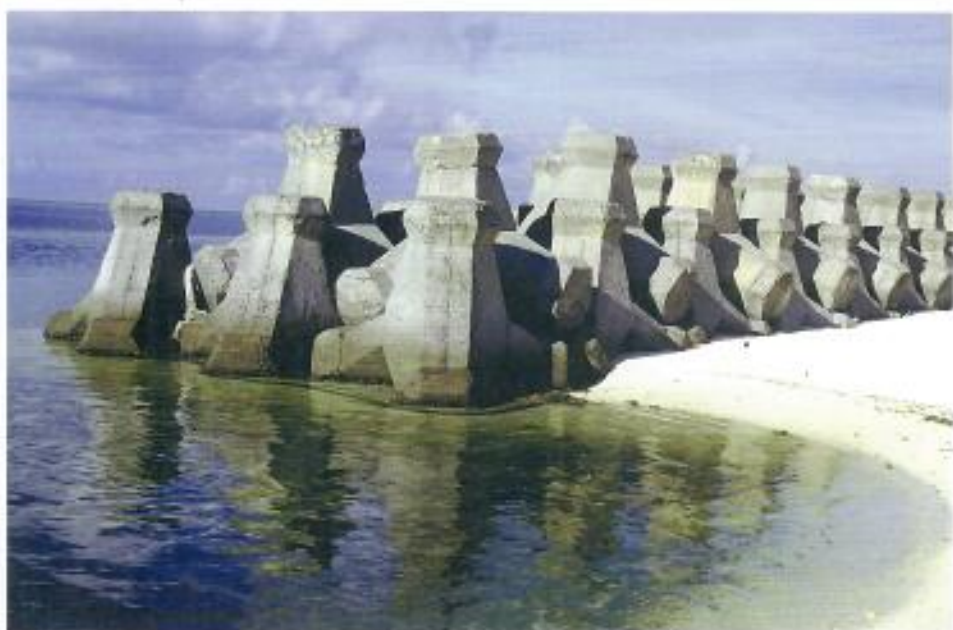
東沙島的沙灘上，堆起數層的消波塊。
