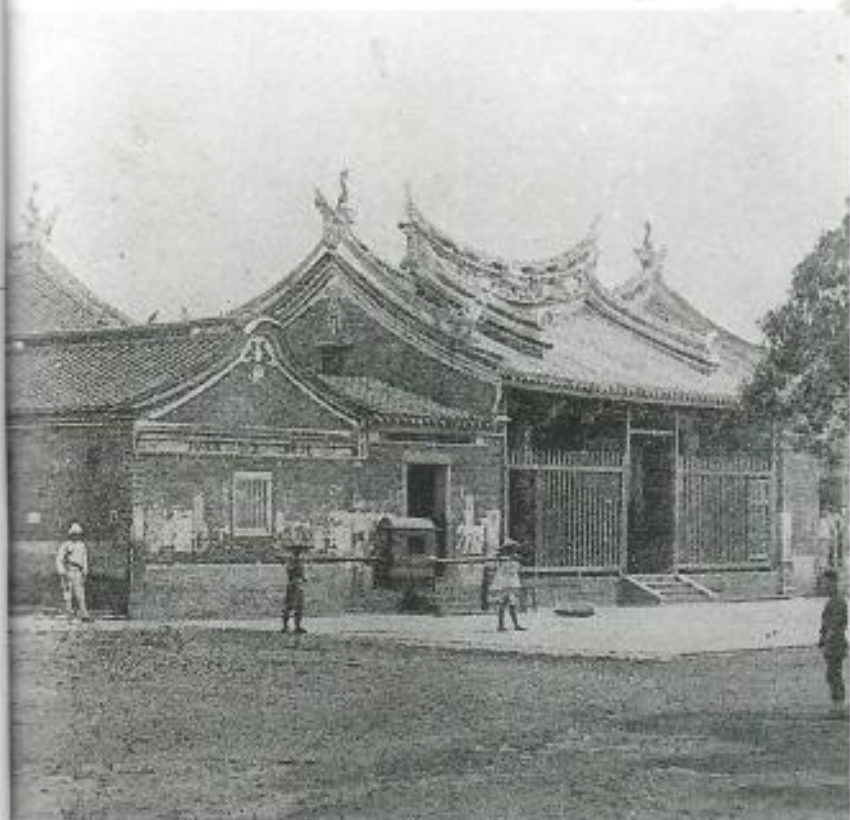
清末重修之後的 恒祥龍山寺，前殿為單簷， 兩旁有退水門及護室。
