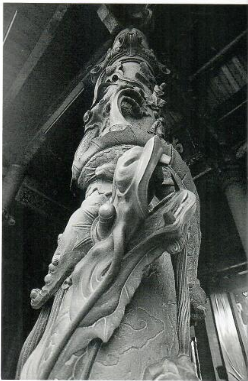
前殿後步柱為石雕龍柱，圓柱盤龍， 龍體轉折有致，氣勢雄健。
