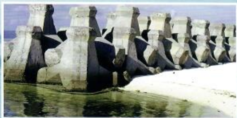
東沙島的沙灘上，堆起數層的消波塊。
